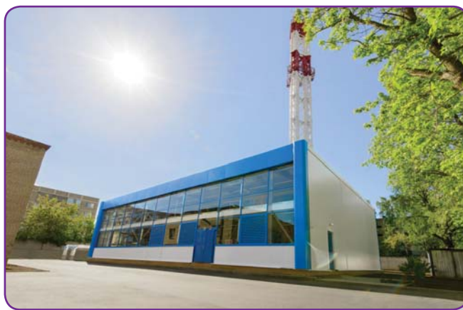
Блочно-модульная водогрейная котельная мощностью 52,3 МВт для жилого микрорайона в г. Домодедово Московской области (ООО «Модульные котельные системы»)
