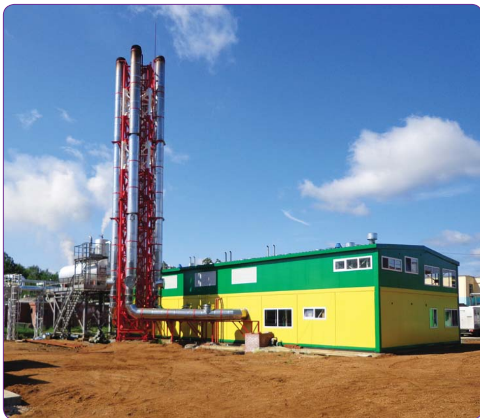
Котельная в пгт Рефтинский (ООО «Завод БМК ЭнергоЛидер»)
