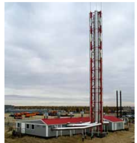
Блочно-модульная котельная мощностью 18,8 МВт и дымовая труба высотой 32 м с теплоизолированными газоходами из нержавеющей стали. Производственная база БПО ООО «Газпром подземремонт Уренгой»
